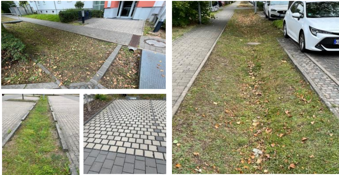
Abbildung 21: Versickerungsbetonte Entwässerungsstrukturen in der Bebauung
