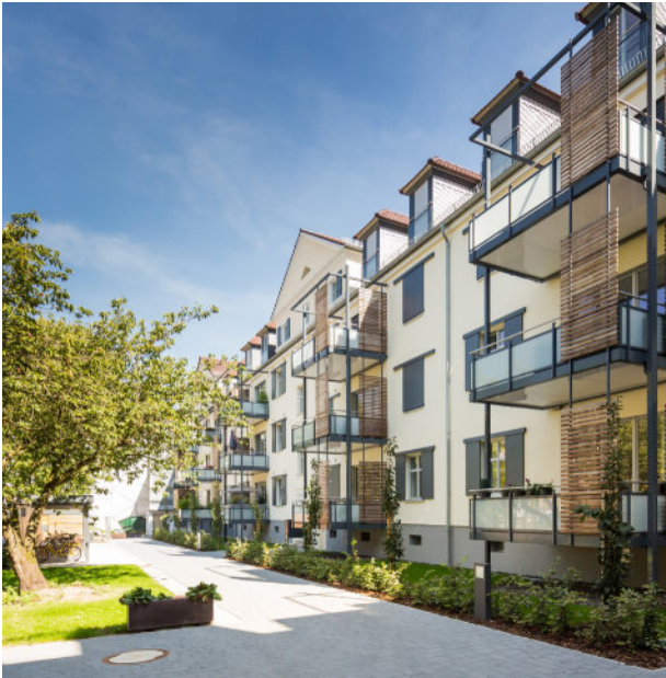
Durch Modernisierung und den Anbau von Balkonen investiert das Wohnungsunternehmen in seine Bestände
