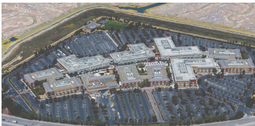
Angrenzend an den Facebook-Firmensitz soll der neue Stadtteil Willow Campus (Kalifornien) entstehen
