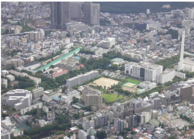
Im dicht bebauten Stadtteil Meguro (Tokio) entsteht das Wohnhaus von »Tomoyuki Kurokawa Architects«
