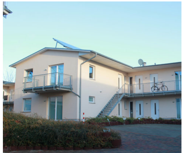
Ein fertiggestelltes Haus mit Mitarbeiterwohnungen
