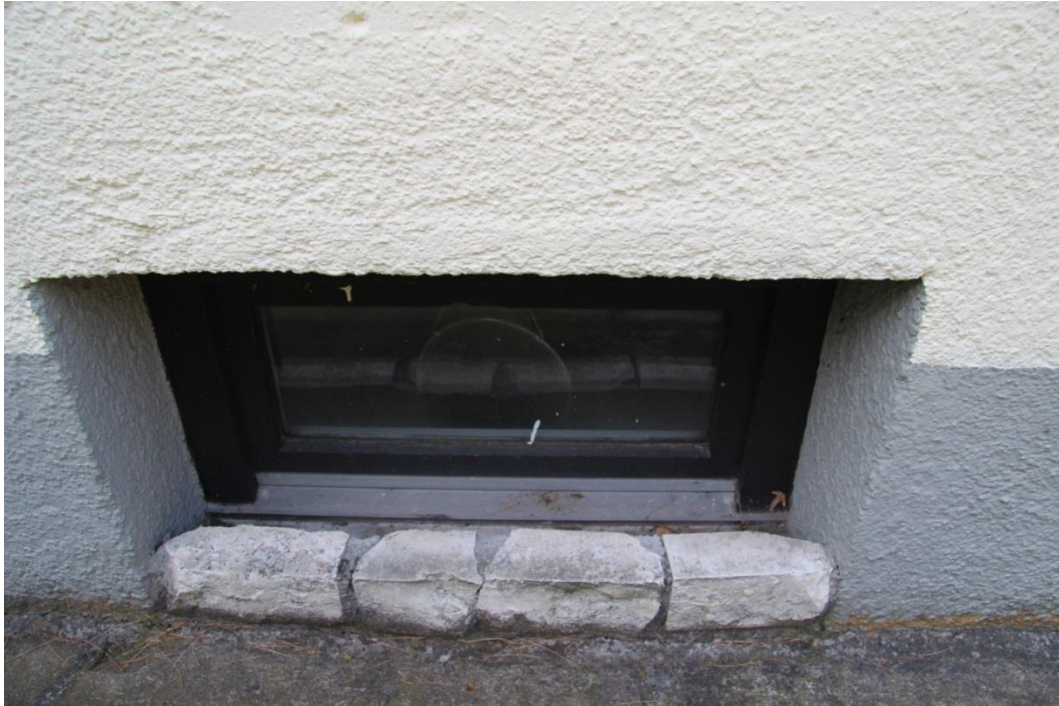
ABBILDUNG 50: GEMAUERTER SCHUTZ GEGEN OBERFLÄCHENWASSER VOR KELLERFENSTER (FOTO: GÜNTHERT 2015)
