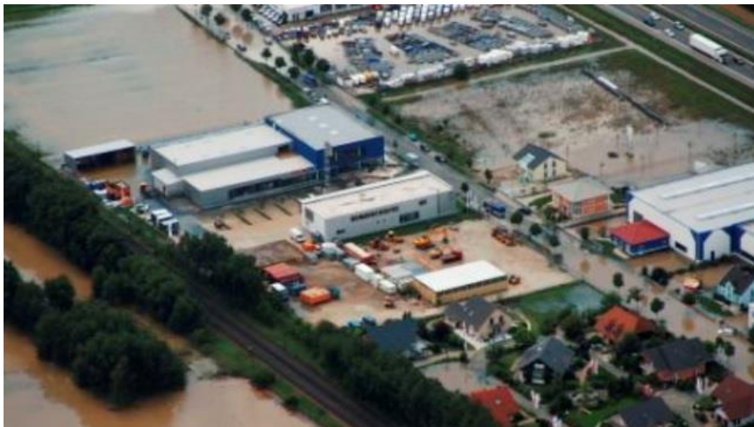
ABBILDUNG 39: ÜBERFLUTUNG GEWERBEGEBIET BAIERSDORF BEI FORCHHEIM (FOTO FREIWILLIGE FEUERWEHR STADT BAIERSDORF (BRUNNER 2008))
