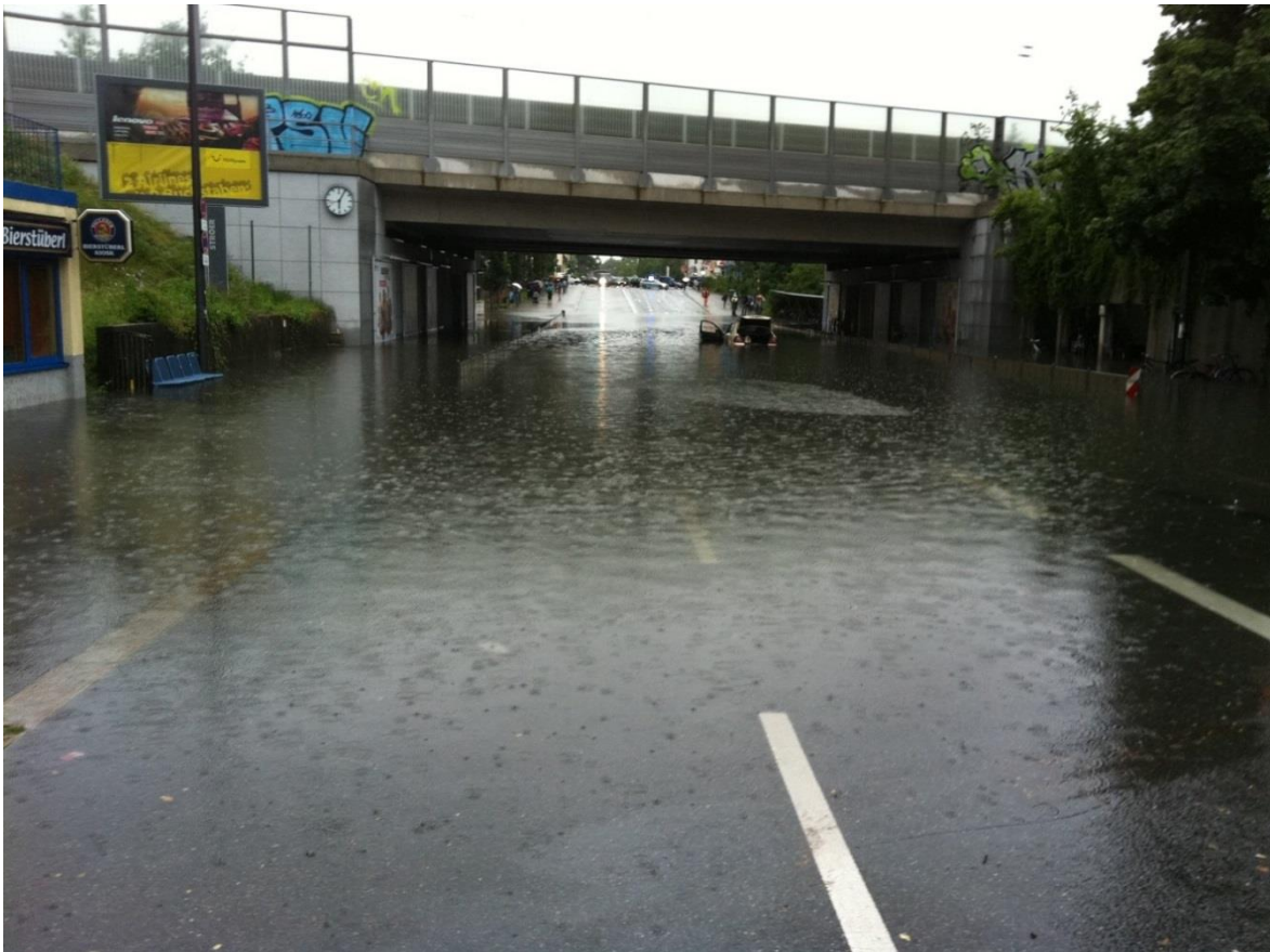
ABBILDUNG 22: ÜBERFLUTETE UNTERFÜHRUNG (FOTO: STADTENTWÄSSERUNG MÜNCHEN)
