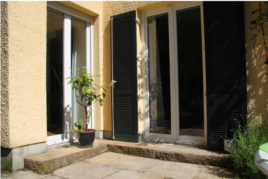
ABBILDUNG 48: TERRASSENZUGANG HÖHERGESETZT FÜR ZUSÄTZ- LICHEN ÜBERFLUTUNGSSCHUTZ (FOTO: GÜNTHERT 2015)
