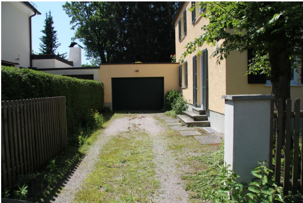
ABBILDUNG 51: ENTSIEGELTE GARAGENZUFAHRT ZUR VERMINDERUNG UND VERZÖGERUNG DES OBERFLÄCHENABFLUSSES (FOTO: GÜNTHERT 2015)
