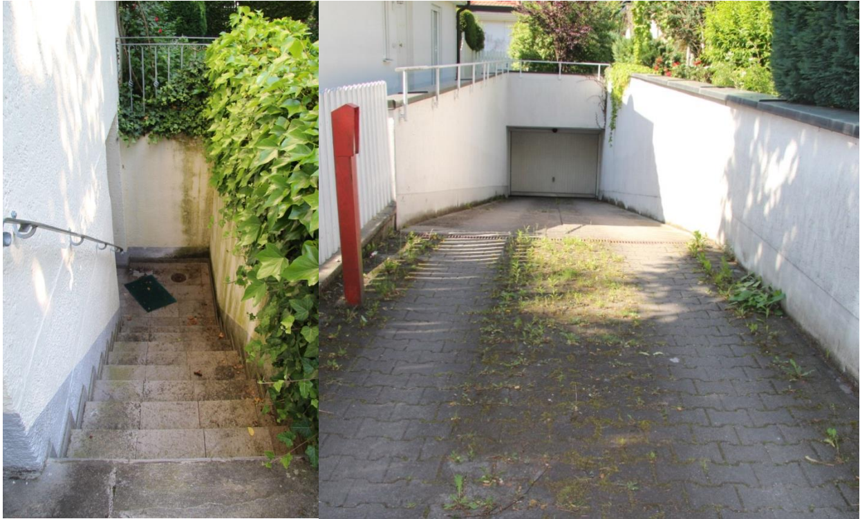
ABBILDUNG 18: GEFAHRENSTELLEN AN GEBÄUDEN. KELLEREINGANG (L) UND TIEFGARAGENZUFAHRT (R) (FOTOS: GÜNTHERT 2015)
