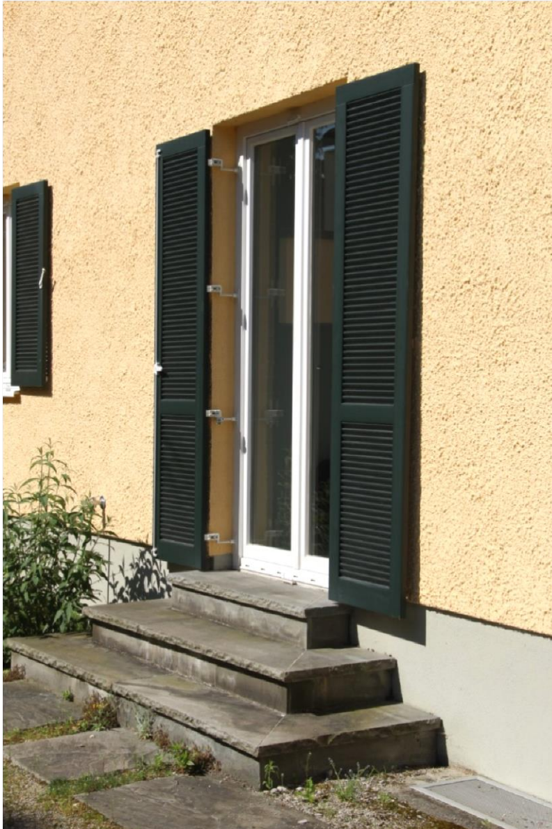
ABBILDUNG 49: HÖHERGESETZTER HAUSEINGANG (FOTO: GÜNTHERT 2015)
