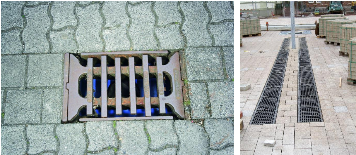
ABBILDUNG 32: VERSCHIEDENE EINLAUFSYSTEME (FOTOS: FUNKE KUNSTSTOFFE GMBH)
