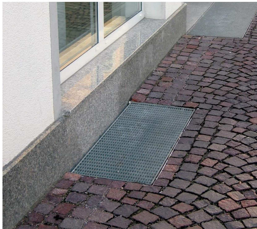
ABBILDUNG 19: KELLERLICHTSCHACHT (FOTO: MEA WATER MANAGEMENT GMBH)
