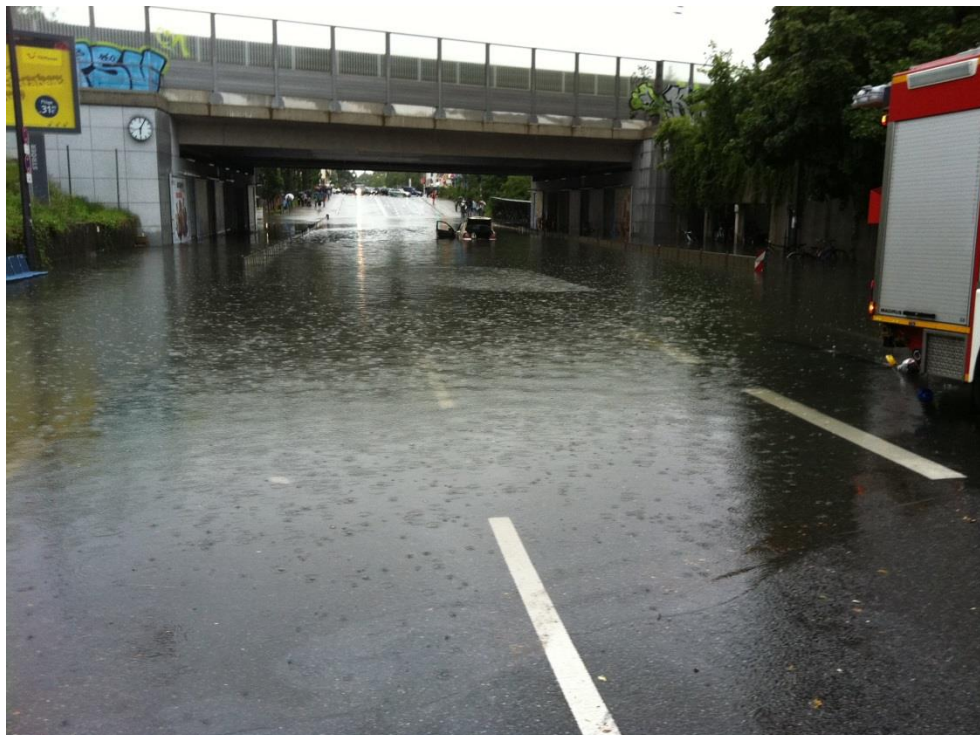
ABBILDUNG 45: ÜBERFLUTUNG DER UNTERFÜHRUNG VERDISTRAÙE IN MÜNCHEN 2011 (FOTO: STADTENTWÄSSERUNG MÜNCHEN)
