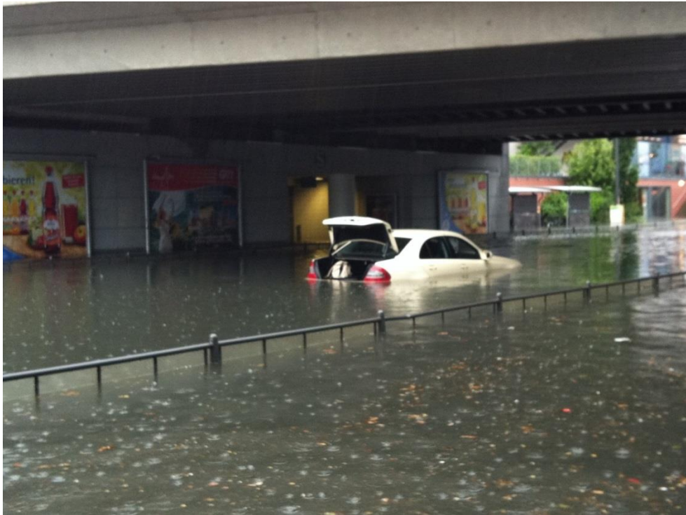
ABBILDUNG 44: ÜBERFLUTUNG DER UNTERFÜHRUNG VERDISTRAÙE IN MÜNCHEN 2011 © (FOTO: STADTENTWÄSSERUNG MÜNCHEN)
