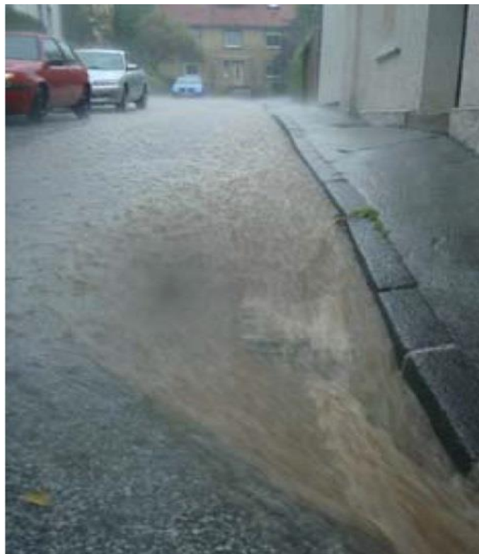
ABBILDUNG 41: ÜBERLASTETE ABLAUFRINNE INFOLGE EINES STARKREGENEREIGNISSES (FOTO: WUPPERVERBAND (SCHEIBEL 2013))
