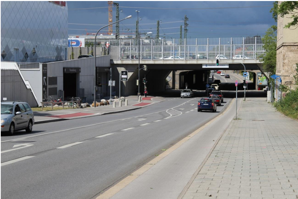
ABBILDUNG 21: UNTERFÜHRUNGSBAUWERK ALS TIEFPUNKT DER ENTWÄSSERUNG (FOTO: GÜNTHERT 2015)
