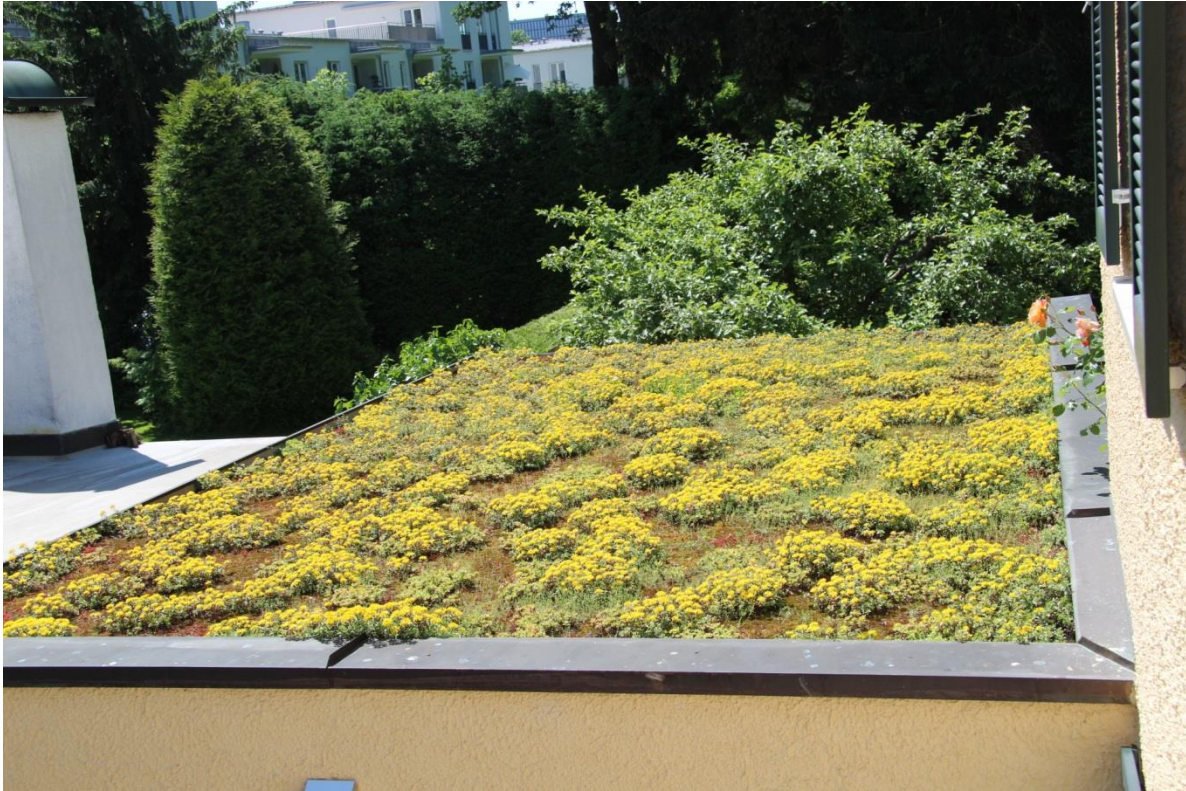
ABBILDUNG 33: GRÜNDACH EINER GARAGE IM URBANEN BEREICH (FOTO: GÜNTHERT 2015)
