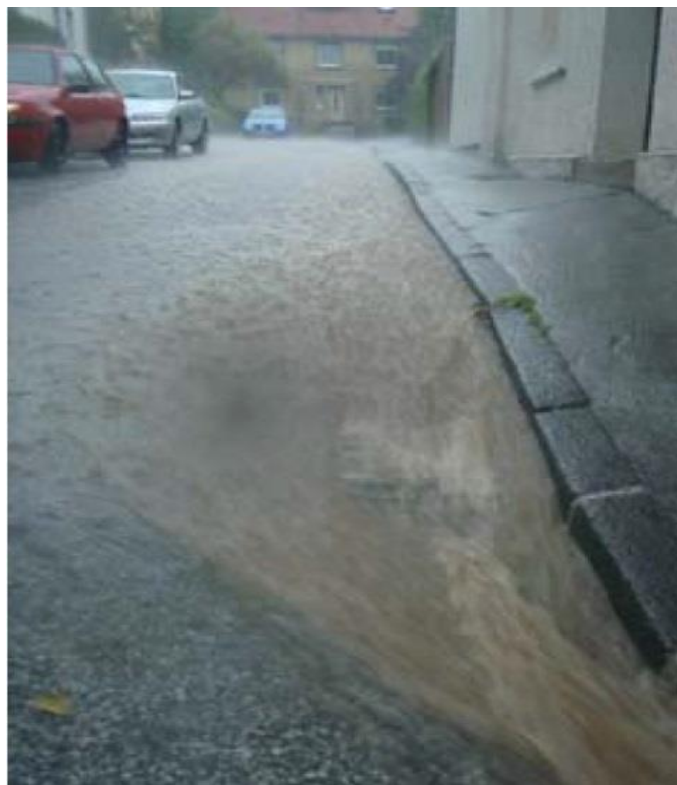
ABBILDUNG 55: ÜBERLASTETE ABLAUFRINNE INFOLGE EINES STARKREGENEREIGNISSES (FOTO: WUPPERVERBAND (SCHEIBEL 2013))
