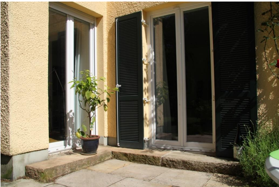
ABBILDUNG 62: TERRASSENZUGANG HÖHERGESETZT FÜR ZUSÄTZLICHEN ÜBERFLUTUNGSSCHUTZ (FOTO: GÜNTHERT 2015)
