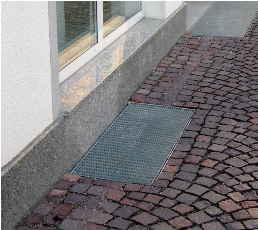
ABBILDUNG 19: KELLERLICHTSCHACHT (FOTO: MEA WATER MANAGEMENT GMBH)
