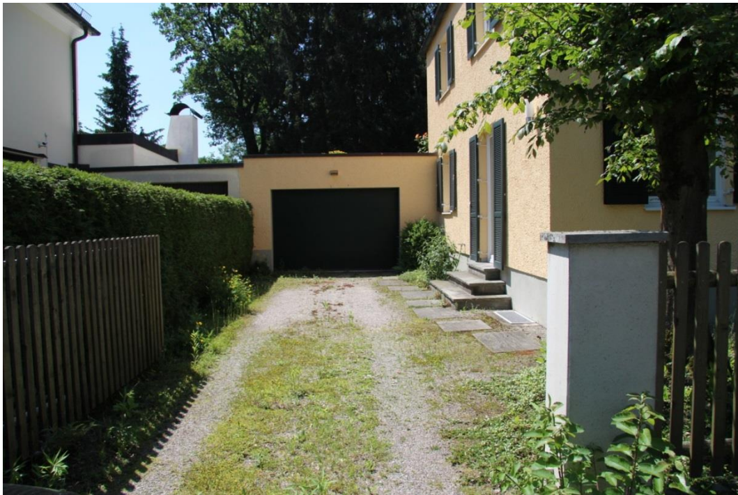
ABBILDUNG 65: ENTSIEGELTE GARAGENZUFAHRT ZUR VERMINDERUNG UND VERZÖGERUNG DES OBERFLÄCHENABFLUSSES (FOTO: GÜNTHERT 2015)
